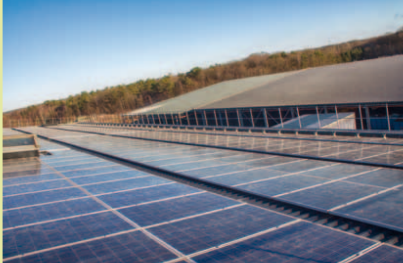
Solcellsanläggning uppförd och installerad.
